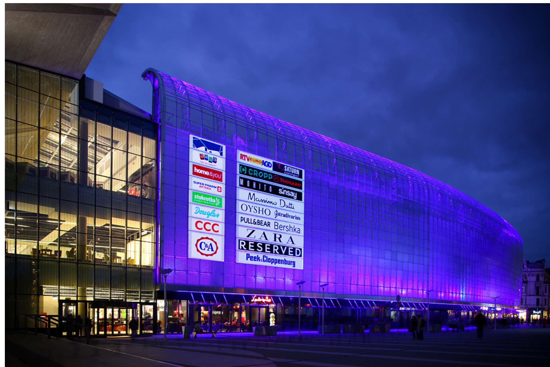
Galeria Katowicka. Katowice
