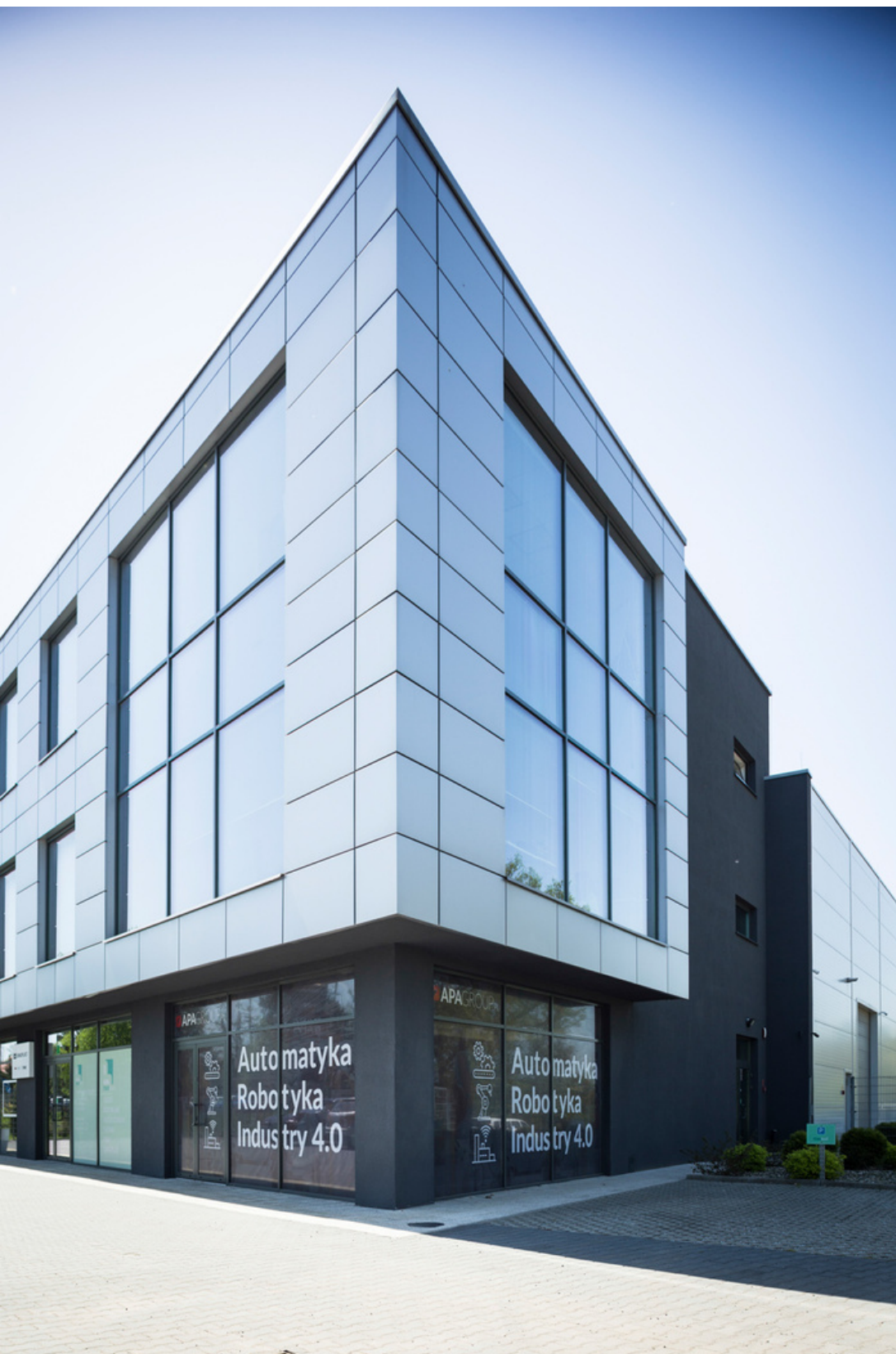
Budynek biurowo-produkcyjny / APA . Gliwice
